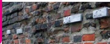
↑4 ポーランド侵襲時に抵抗し、降伏・処刑された人々の手形をモチーフとした追悼の壁 (ポーランド グダンスク)
